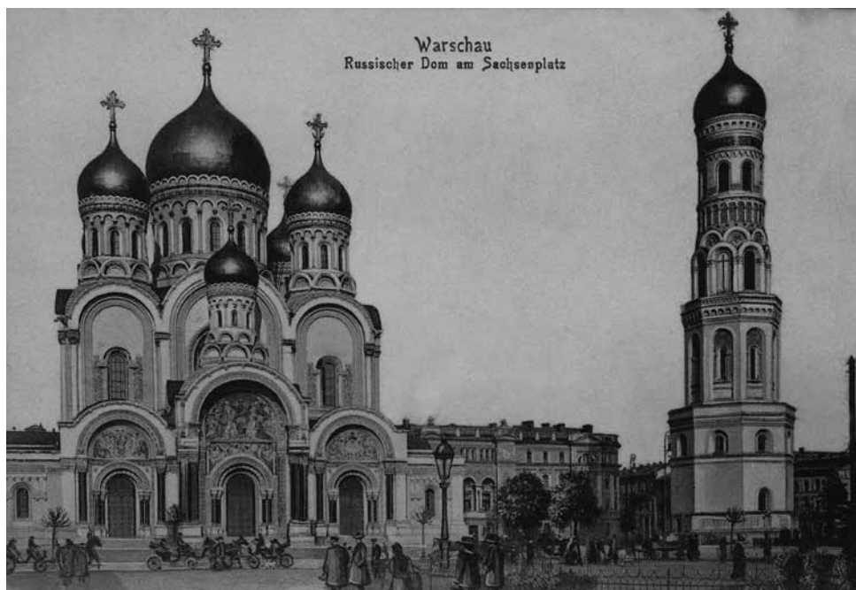
Niemiecka pocztówka z Warszawy przedstawiająca, jak głosi napis: „rosyjską katedrę na pl. Saskim”. Po prawej stronie soboru narożnik prawego skrzydła pałacu Saskiego; w głębi ulica Królewska (fot. NAC)
