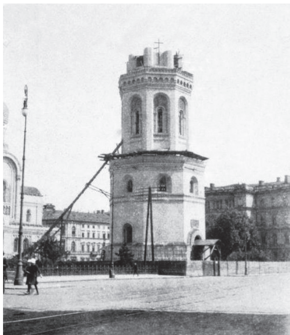
Dzwonnica soboru św. Aleksandra Newskiego w Warszawie w trakcie rozbiórki, wiosna – lato 1921 r. (ze zbiorów Imperial War Museum) 86
