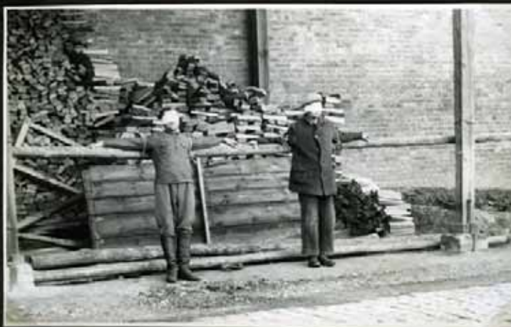
Zum Post verurteilte Freisquartier vor der Erschließung.
