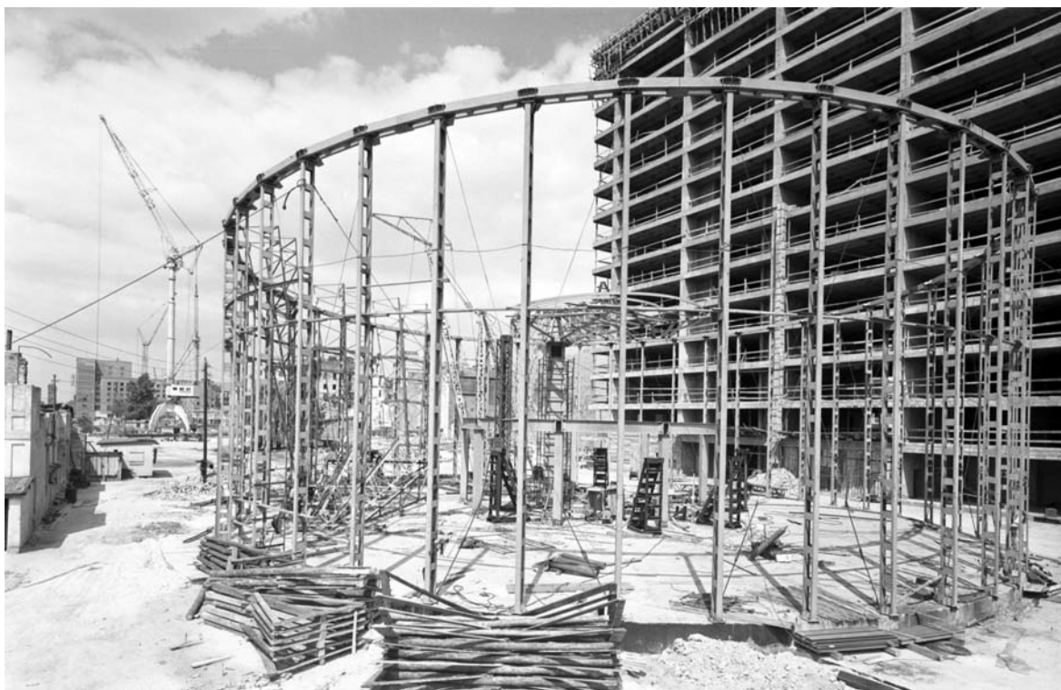
Budowa Rotundy PKO w Warszawie w latach 1962–1963. Z prawej widoczny fragment budowanego gmachu Universalis (Narodowe Archiwum Cyfrowe)
