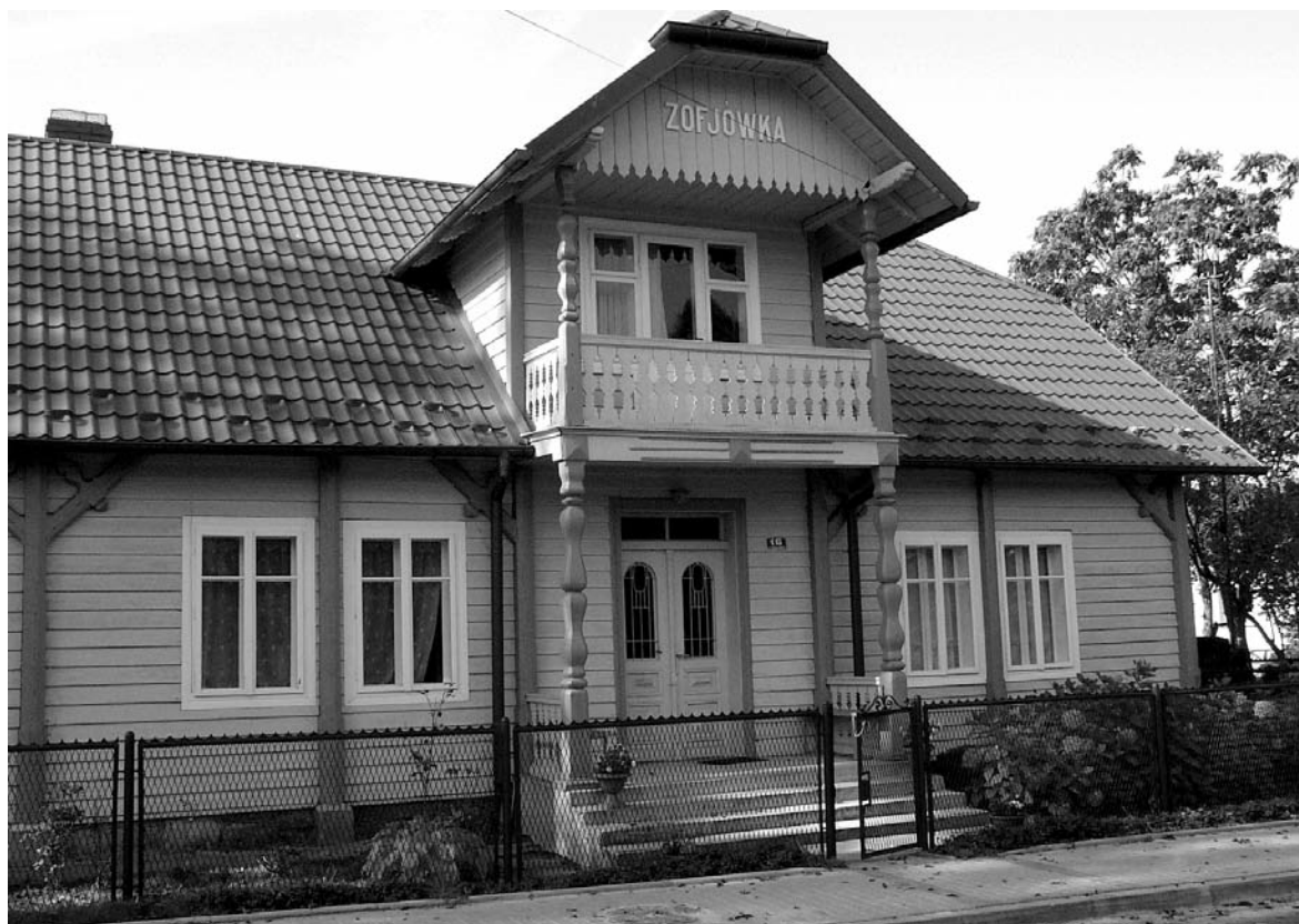
Zakliczyn, ul. Jagiellońska, willa „Zofiówka”, stan obecny (fot. R. Kotarba)
