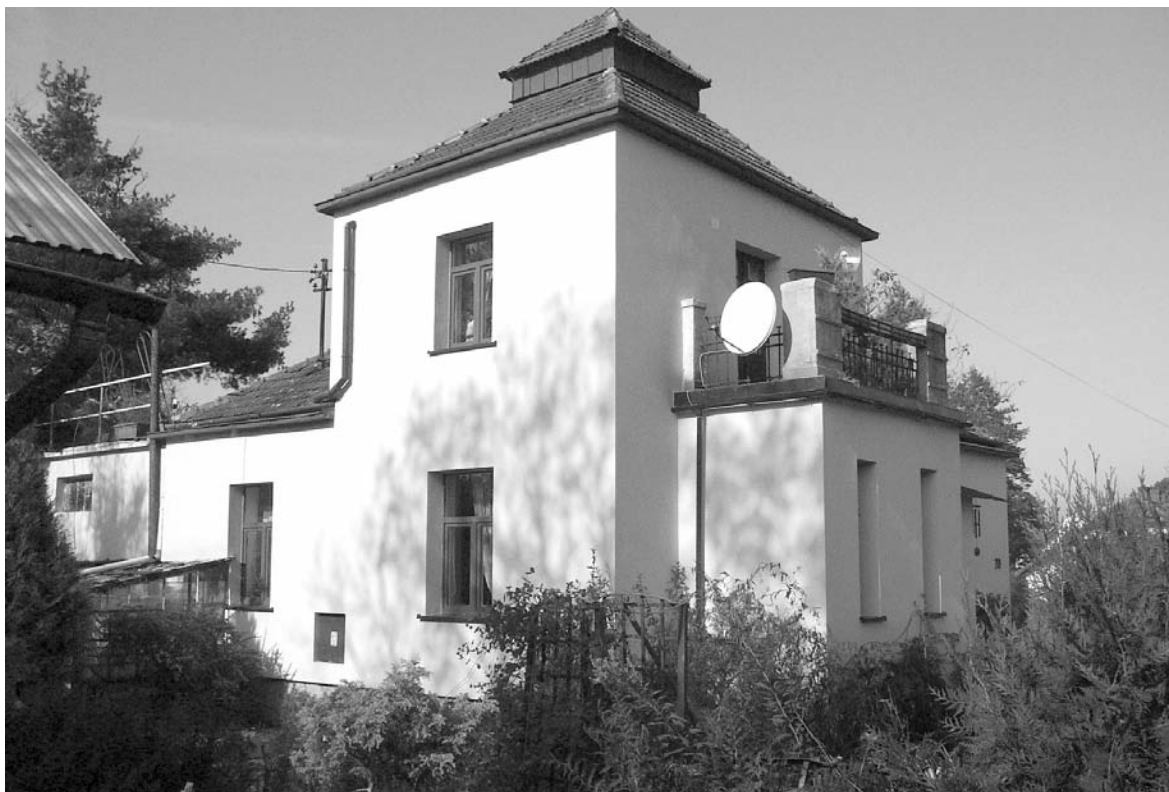
Zakliczyn, ul. Jagiellońska, willa „Koci Zamek”, stan obecny (fot. R. Kotarba)
