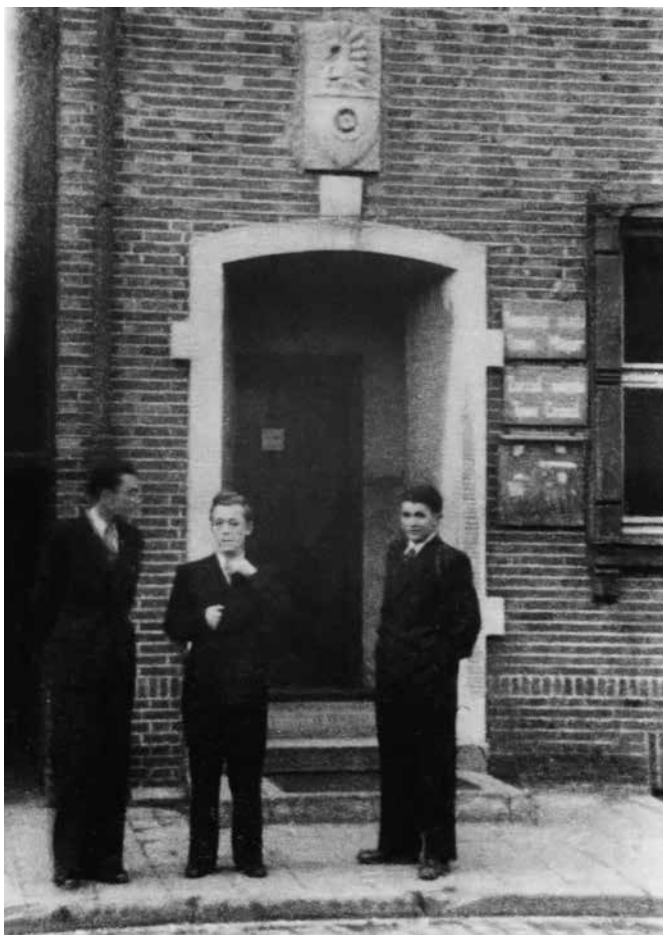
Wejście do budynku polskiej administracji miejskiej przy Kirchstraße / ul. 1. Dywizji Pancerniej. POSK
