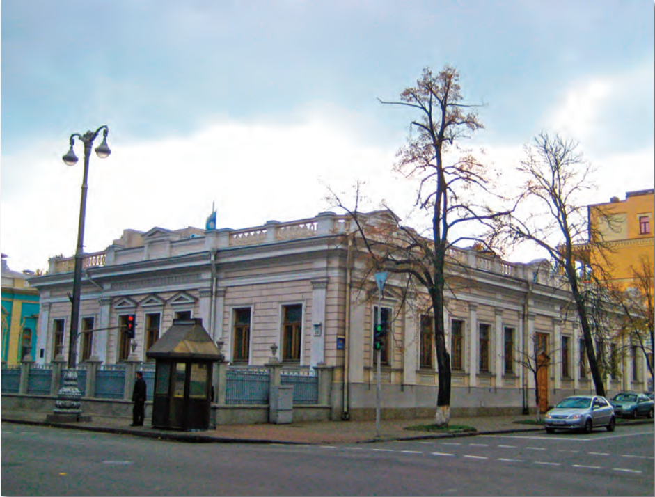
Obecny wygląd budynku przy ul. M. Hruszewskiego 20, w którym znajdował się polski konsulat w latach 1926–1939 (fot. W. Okipniuk)
