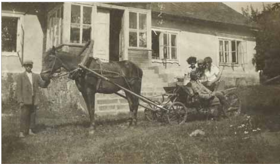
Dwór w Gierkanach, fot. z albumu Heleny z Zanów Stankiewiczowej
