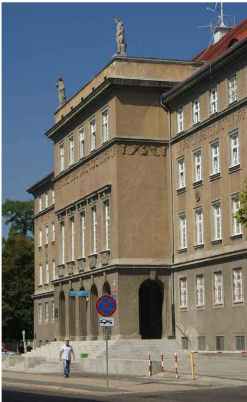
Gmach Komendy Wojewódzkiej Policji w Opolu (zbudowany w okresie międzywojennym jako siedziba Dyrekcji Kolei Rzeszy). Do 1990 r. siedziba KW MO i WUSW (fot. Zbigniew Bereszyński)
