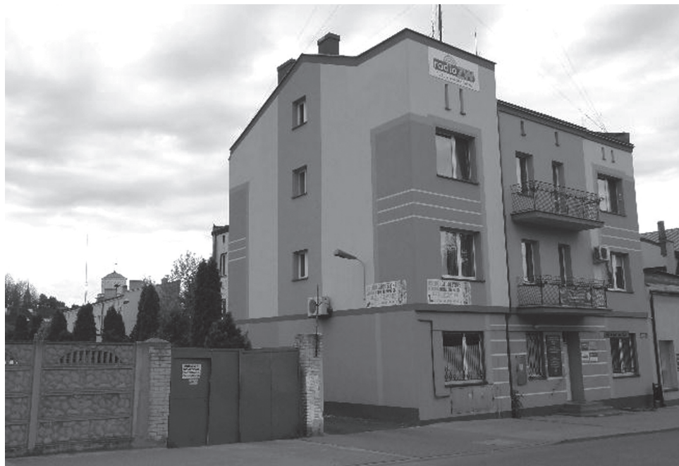
Budynek przy ul. Kilińskiego 23 w Wieluniu, gdzie mieścił się PUBP (obecnie siedziba Radia Ziemi Wieluńskiej, fot. K. Jasiak)
